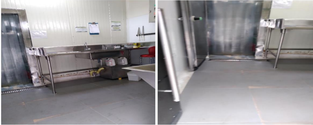
Fotografías No.1 Espacio existente para el mantenimiento y/o adecuación de los cuartos fríos del CESAP.
