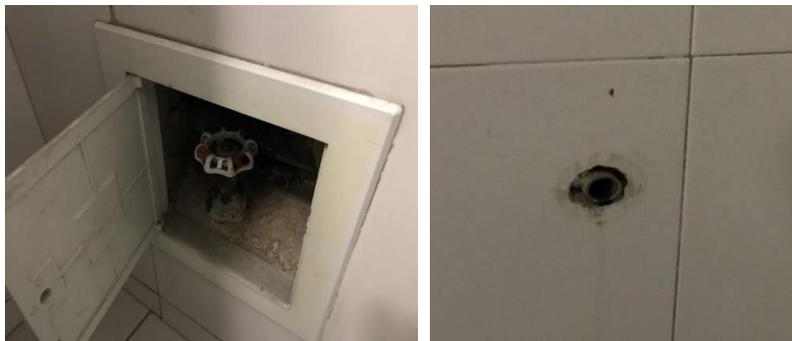
Fotografías **No.2** Se evidencia el mal estado de registros de paso, terminales de accesorios
