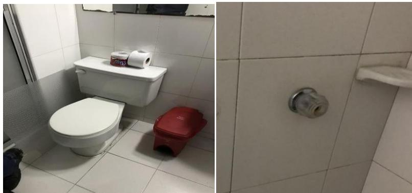
Fotografías No. 5 Aparatos sanitarios: Los aparatos existentes son obsoletos y en mal estado y por consiguiente consumen más agua, como ejemplo podemos mencionar los inodoros actuales que tienen tanque de capacidad de 15 lts
