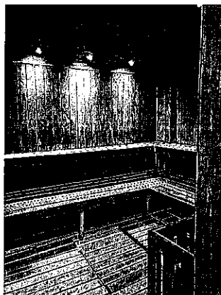
Fotografía No.13 Área de sauna en mal estado en general.
