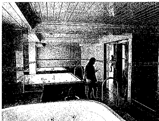
Fotografía No.17 Cielo rasos no funcionales para espacios húmedos. No cumplen con la normatividad.
